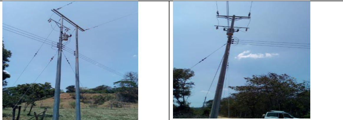
Instalación de postes y redes eléctricas.
