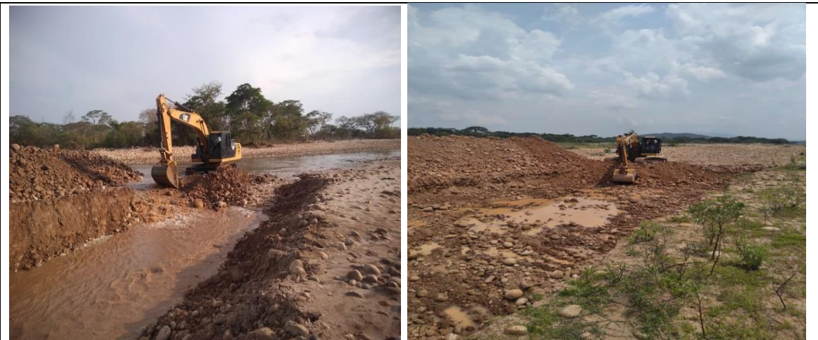
Intervención río Ariporo en las veredas Elvecia, Carrastol y Sabanetas
