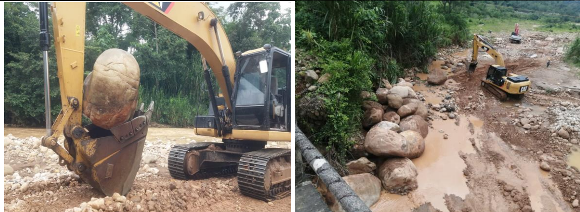
Intervención de la socavación sobre costado derecho aguas debajo del puente sobre la quebrada La Curuche
